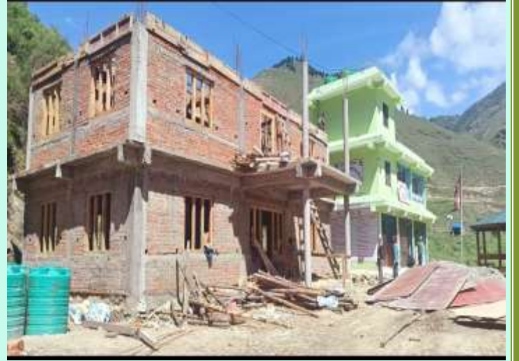
तातोपानी गाउँपालिकाको आन्तरिक श्रोत बाट बन्न लागेको निर्माणाधिन प्रशासकीय भवन
