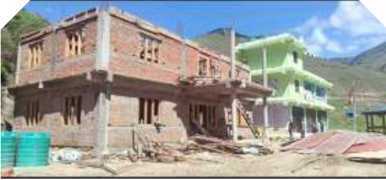
गाउँपालिकाको प्रशासकीय भवन निर्माणाधिन: १
